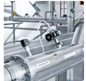
Einspeisestelle für Sekundärluft
