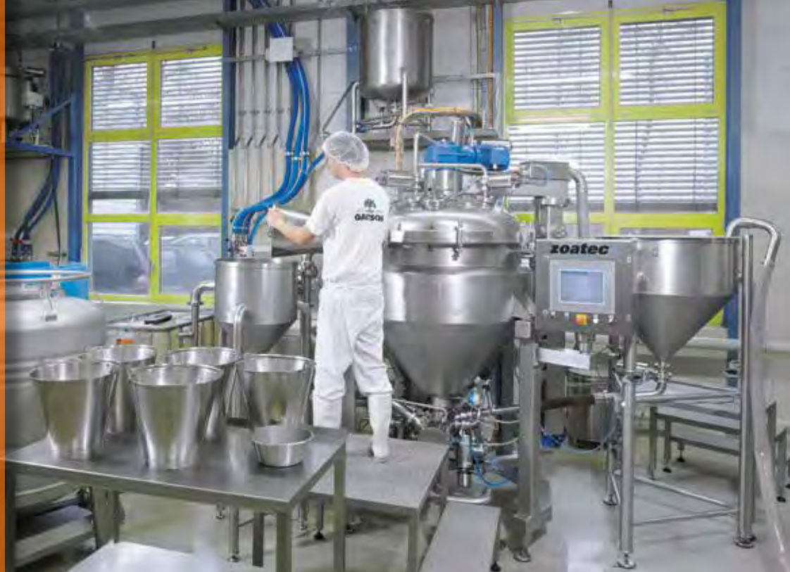
Zugabe von Trockenstoffen und Flüssigpremix über einen Vorlagebehälter
